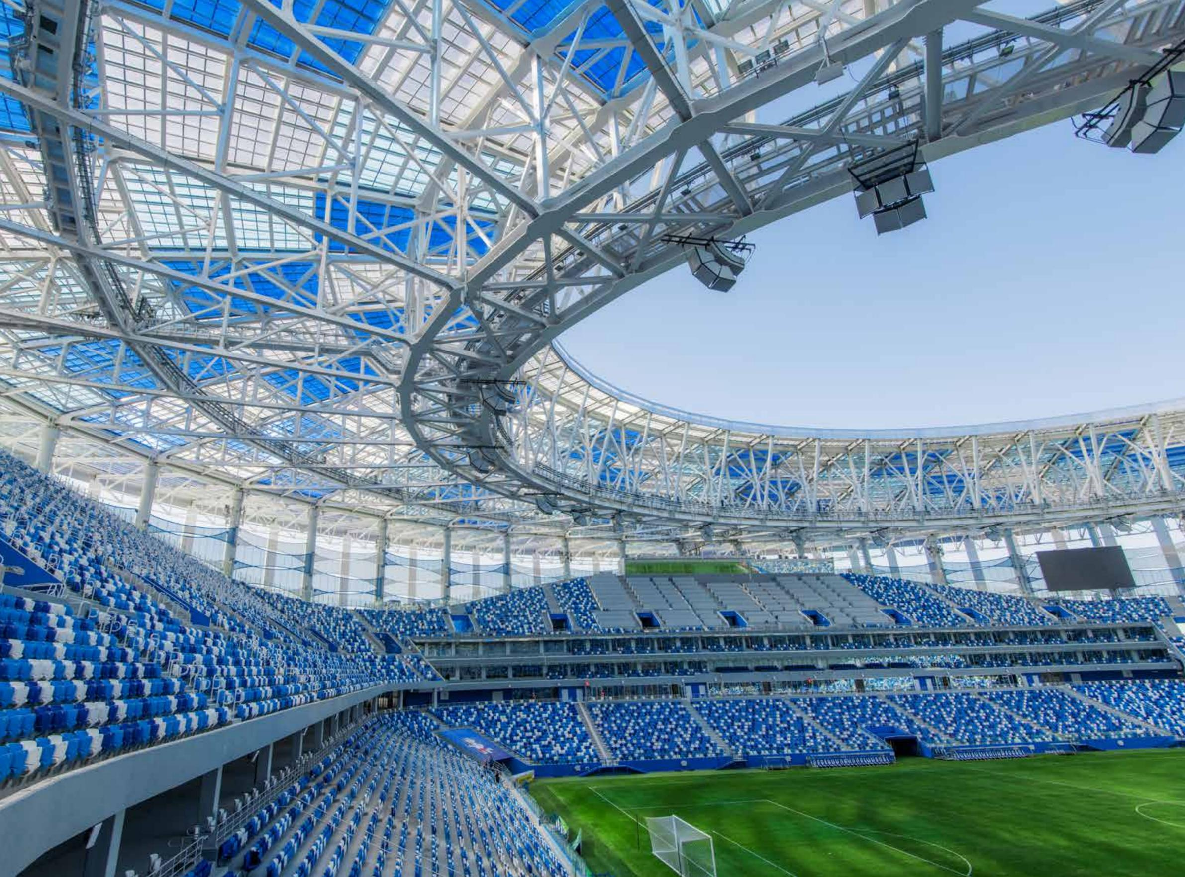
суток фасад украшает архитектурная подсветка. На пояс из круглых опорных колонн установлена ветрозащитная мембрана белого и синего цветов. Похожие на паруса, полотна создают визуальный эффект, при котором стадион выглядит как корабль, стоящий в бухте под надежной защитой гигантских стражей – треугольных колонн. Общая площадь полотен – более 10 000 м<sup>2</sup>.
