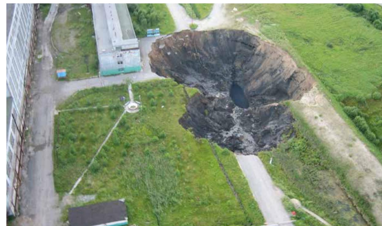
Рисунок 4. Провал на участке прорыва пресных вод в рудник БКПРУ-1 (г. Березники)
