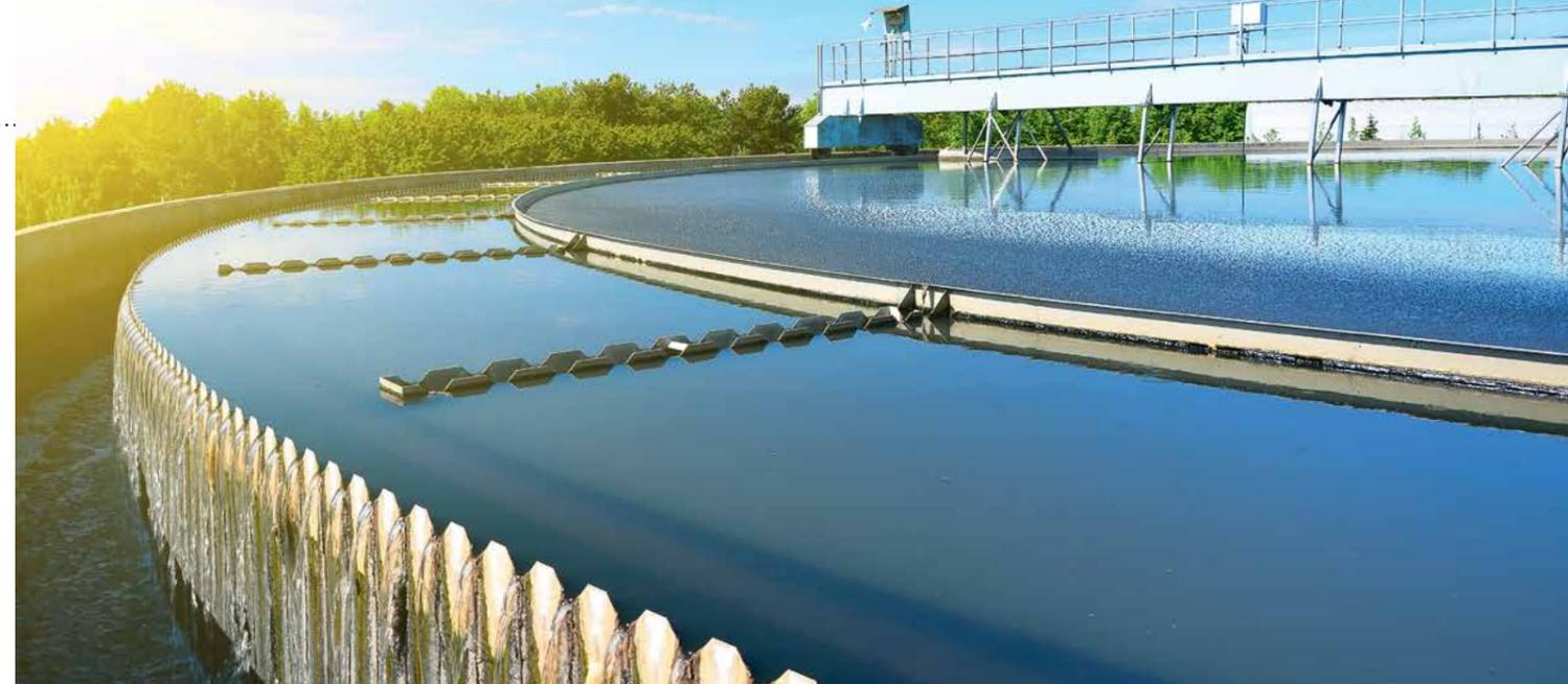
Проектная производительность действующей НФС — 50 000 м<sup>3</sup>/сутки, фактическая производительность — 25 000 м<sup>3</sup>/сутки. В связи с этим 50% сооружений (левая часть НФС) в схеме очистки речной воды оказались не задействованы.
