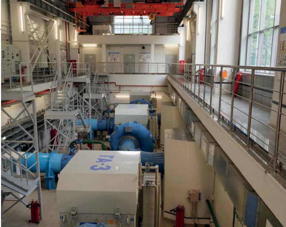
ловной узел, деривацию и напорно-станционный узел. По своей конструкции Верхнебалкарская МГЭС является деривационной гидроэлектростанцией с подводящей деривацией в виде тоннелей, лотков и напорного трубопровода.
