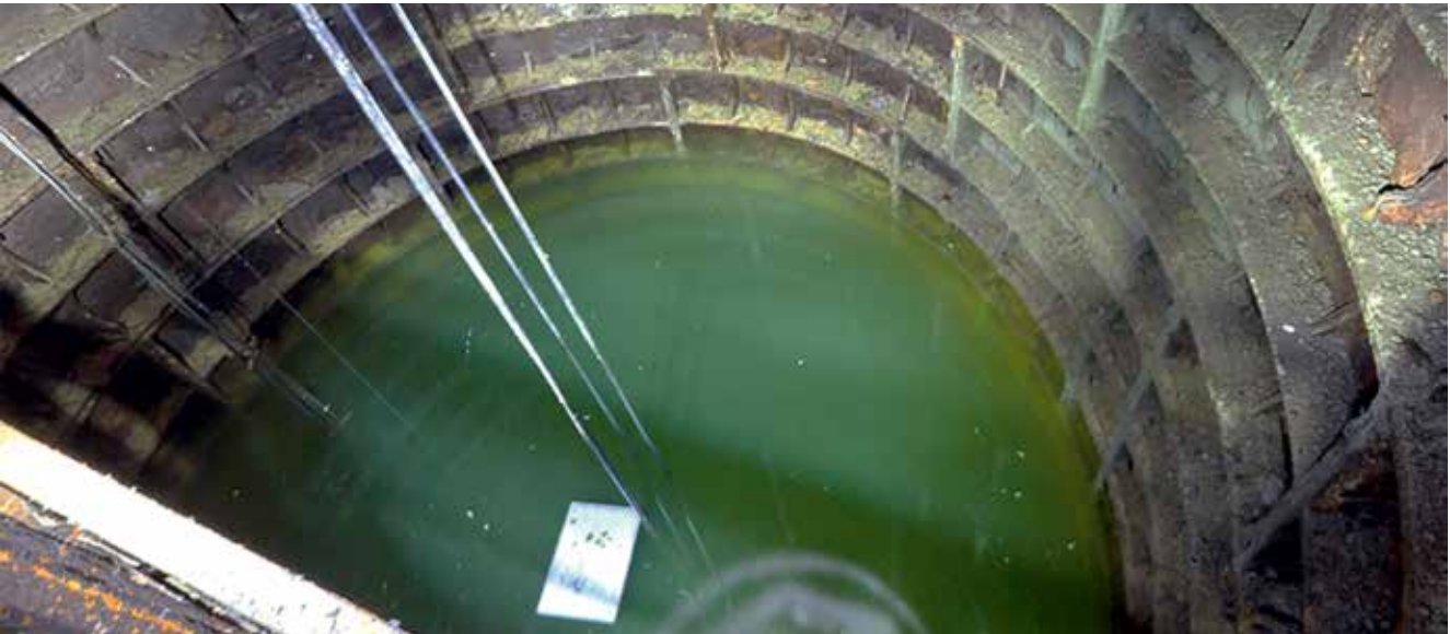
Рис. 2. Аварийное затопление ствола
