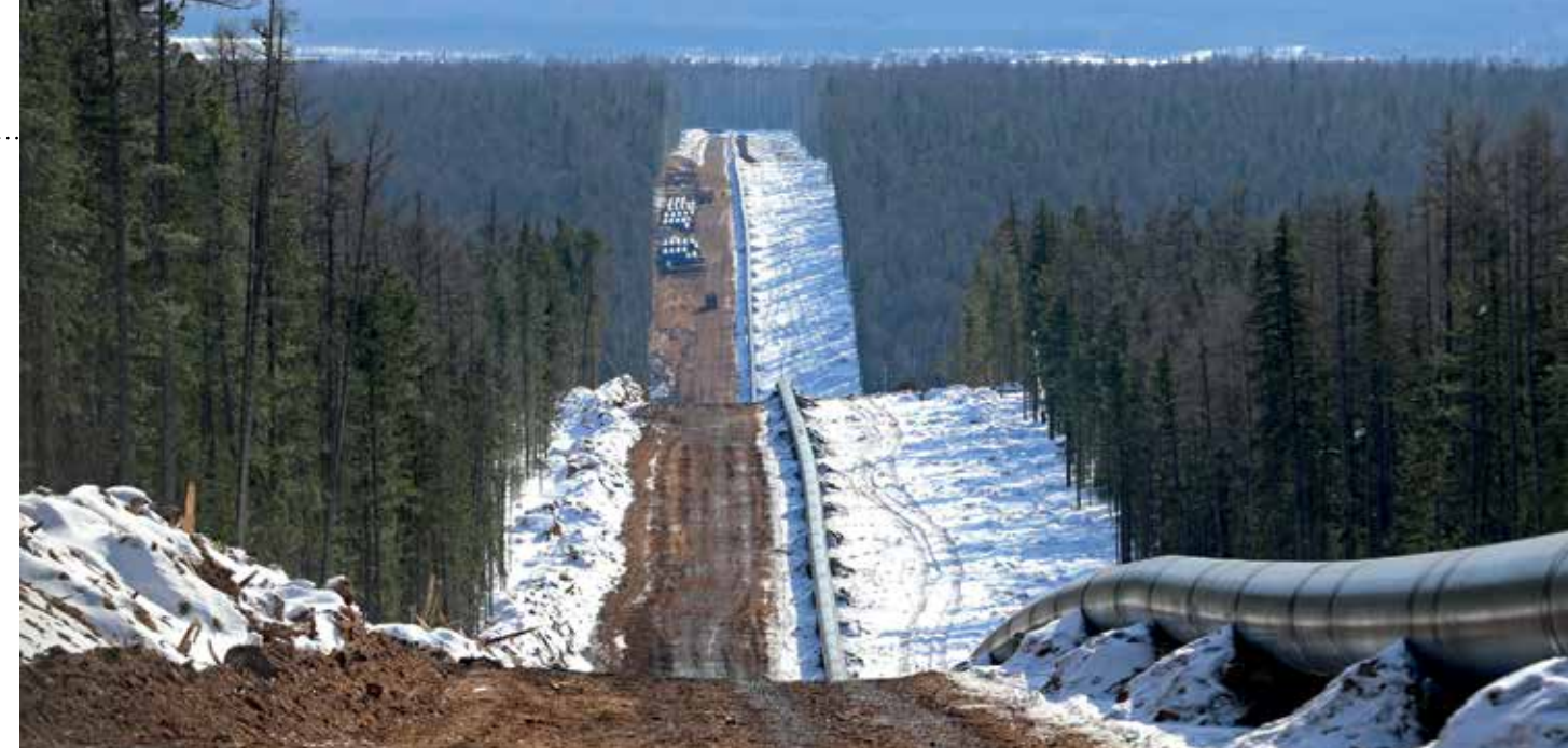
Трасса газопровода «Сила Сибири». Фото: ПАО «Газпром»
