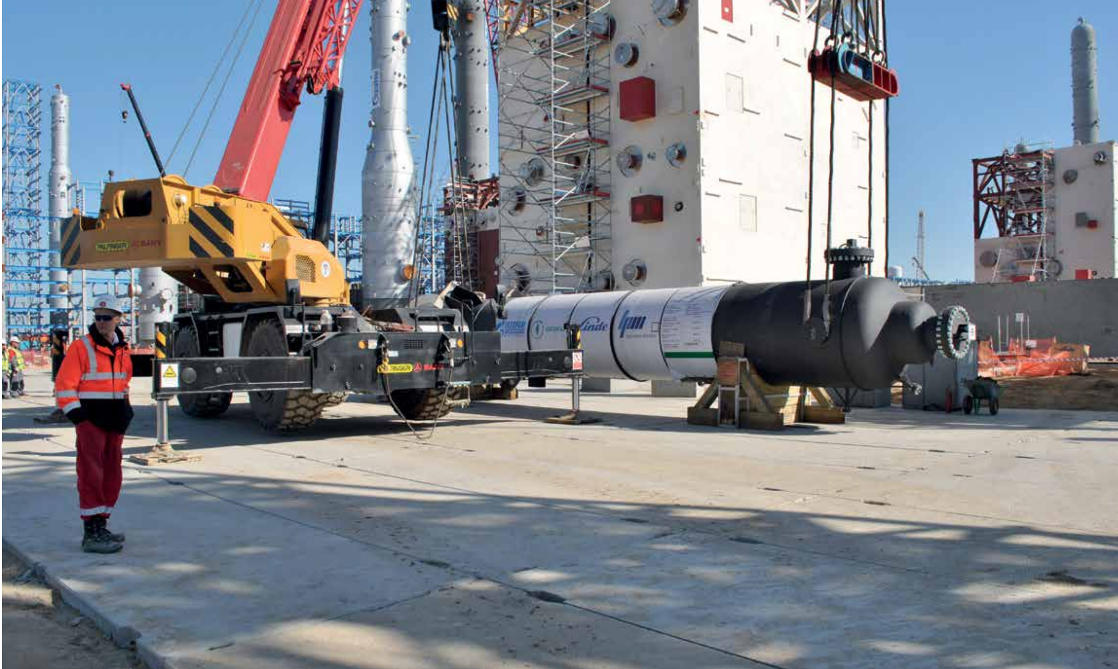
Строительная площадка Амурского ГПЗ. Фото ПАО «Газпром»
