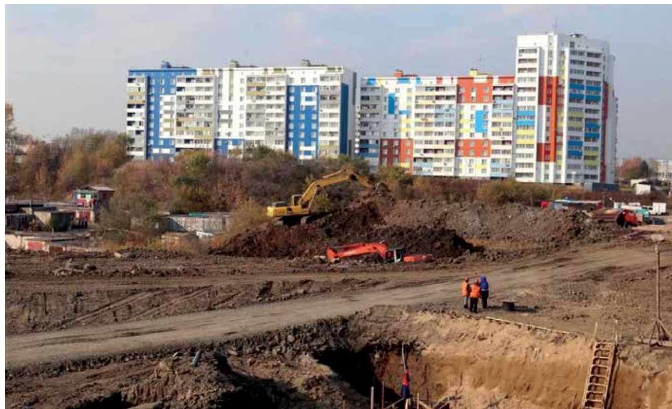
Стройплощадка Дальневосточного учебно-спортивного центра
