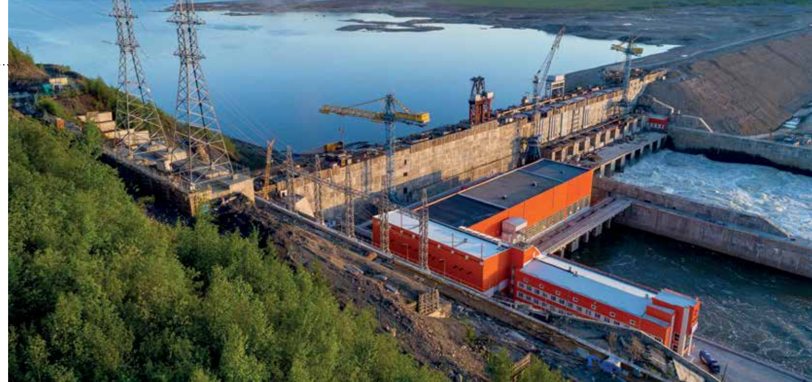
Усть-Среднеканская ГЭС. Фото: ПАО «РусГидро»
