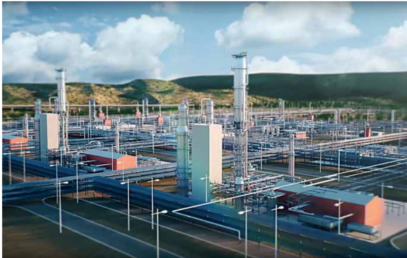
Проект Амурского газоперерабатывающего завода. Фото ПАО «Газпром»
