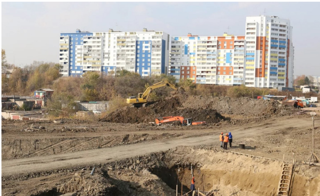
Стройплощадка ДВ учебно-спортивного центра
