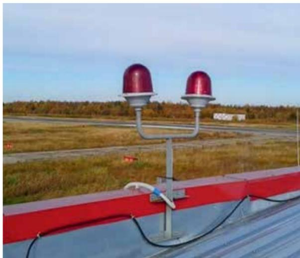
ного транспорта (крановые установки, высотные сооружения и дома, дымоходные трубы, ретрансляционные мачты), световой маркировки протяженных объектов и для постоянного свечения на наземных объектах в качестве сигнального огня.
